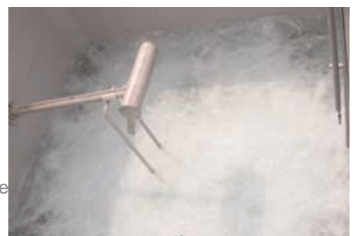
Difusores de tubo en operación
