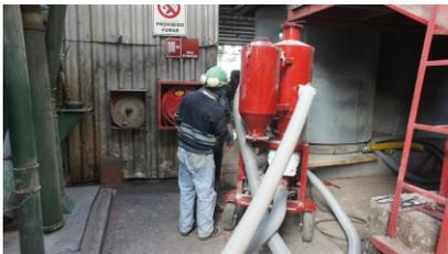
**Limpieza foso de elevador para maíz a 10 mts, profundidad y 20mts de túneles – 25hp**
